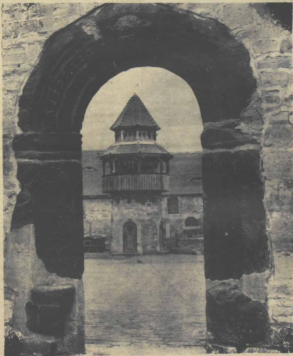
Oberörlingen: Blick durch den alten Torbogen des Rittergutes auf dem Gutshof.
