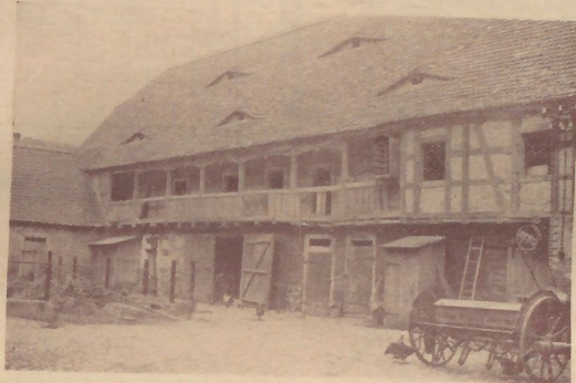
Teil des alten Gasthofes von Mehlfeld. Einst Tanzsaal, jetzt Stall- und Lagergebäude.
