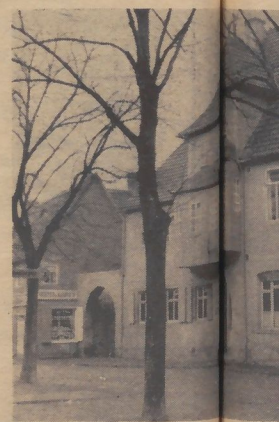
Gaffhof am Marktplatz. Im Saale des alten „Der“ statt.
