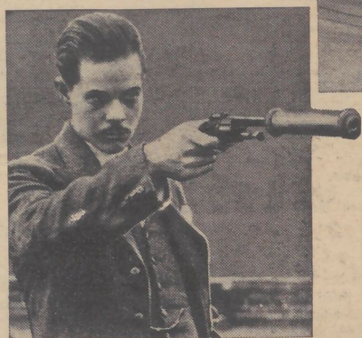
Ein Schalldämpfer für Schusswaffen. Der Engländer Ronald Chapman hat einen Schalldämpfer für Revolver, Gewehre und Maschinengewehre erfunden, der den Schußschall erheblich abschwächt und Rauch und Feuer aufzehrt.
