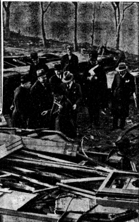
Die Trümmerstätte auf der Betsubahn, wo ein Wagen aus den Gleisen sprang und an einem Hochleitungsast zer-schellte. Bekanntlich fanden bei diesem Unglück 7 Personen den Tod, während 9 Fahrgäste schwere Verletzungen erlitten.
