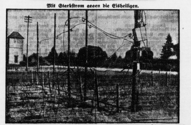
Bei einem Aben hat man einen neuen Versuch gemacht, um die durch Wasserfälle den Wehrströmen drabben Schäden abzumenden. Die Wehrströme wurden durch Stauffrom den man eine Überlaufzentrale entnommen, künstlich geleitet, wodurch eine Temperaturerhöhung um 2 Grad erzielt werden konnte. Gegenüber der bisher üblichen Einräufung mit Testeuren und Men bedeutet diese Verfahren zweifelslos einen Fortschritt, um so mehr, als die Stauffrom während der Nacht sehr billig ist.
