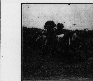
Der Mutterboden wird abgetragen.
