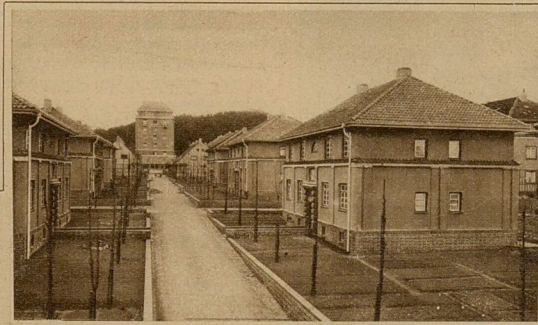
Fertige Häuser aus Müllsteinen
