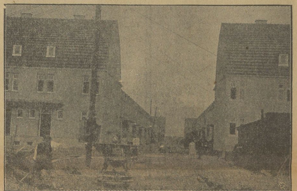
Die Siegfriedstraße im Bau.
