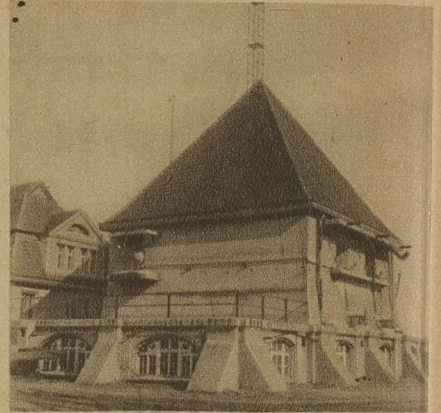
Das Sendehaus mit Antenneneinführungen
