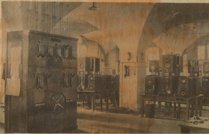
Blick auf das Inlandsfunknetz (500-Watt-Röhrensender). Links der Antennenschalter für die großen Sender
