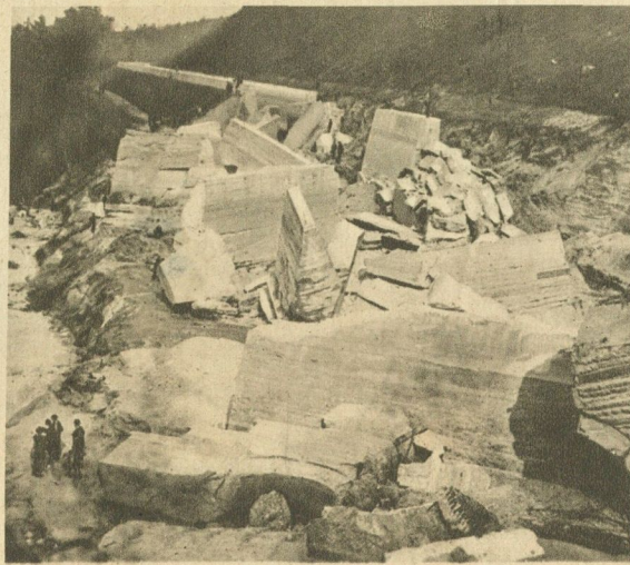
Der Kanalmauerbruch bei den Alzwerken (Oberbayern) Die herabgerissenen riesigen Betonblöcke auf unserem Bilde zeugen von der verheerenden Gewalt der entseelten Fluten Phot. Hans Raepfle
