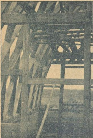
Abb. 5. Durchblick ins Lamellendach beim Fundament.
