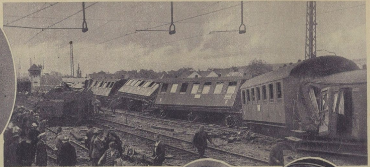
Das Eisenbahnunglück bei München Der beschleunigte Personenzug Regensburg—München entgleiste bei der Station Langenloos bei Zessing infolge einer fahrbahnen Weiche. Das Unglück forderte zahlreiche Tote sowie eine große Zahl Verletzte und Schwerverletzte. Das Bild zeigt den Schauplatz der Katastrophe, links der aus dem entgleisten Zug herausgeschleuderte Personenzug (Kester & Co.)
