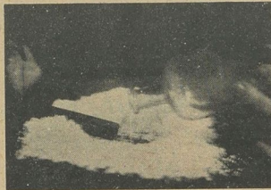
Anrühren des Fensterkittes.
