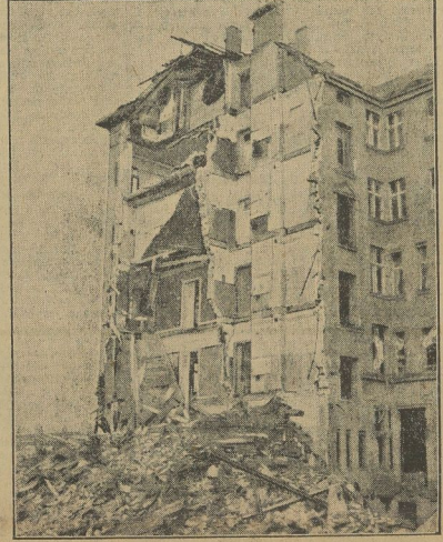
Das Unglückshaus mit der vom Keller bis zum Dachgeschoß aufgerissenen Seitenwand.
