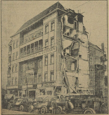
Das Unglückshaus mit der vom Keller bis zum Dachgeschoß aufgerissenen Seitenwand.
