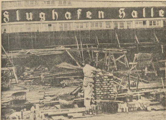
Noch sieht man über der Baugrube das alte Gelände
