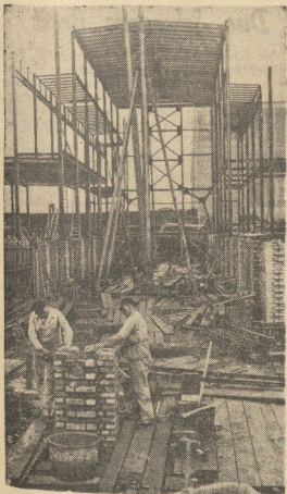
Das Stahlskelett ist schon zu sehen
