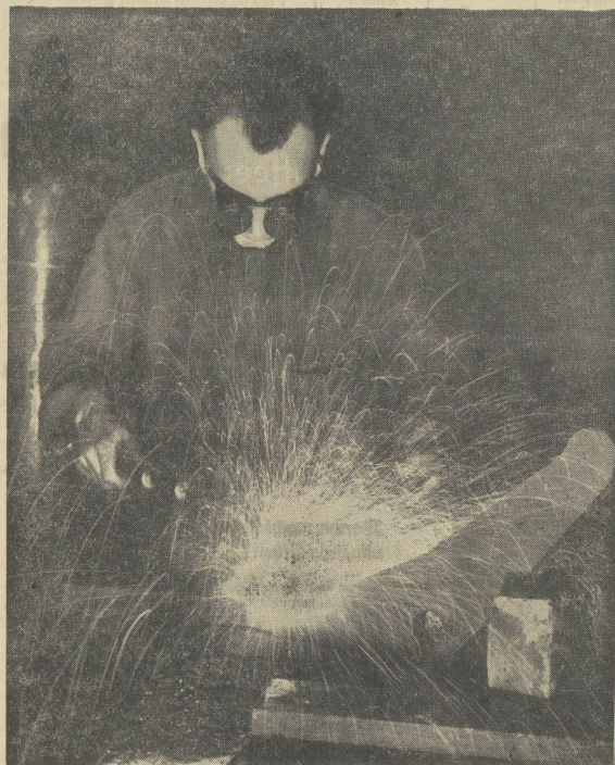
Beim Bau der Brücken spielt das Schweißen eine große Rolle
