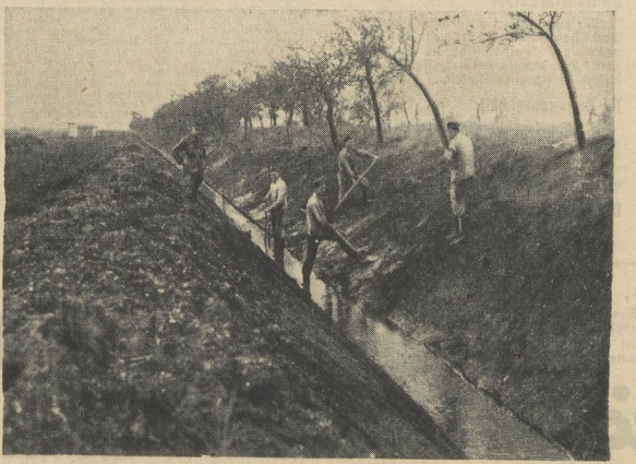
Ein neuer Graben entsteht
