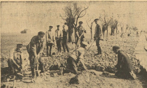
Stein an Stein Sehen der Packlagesteine am Wegebau Voigtsiedl-Nikolausriedl
