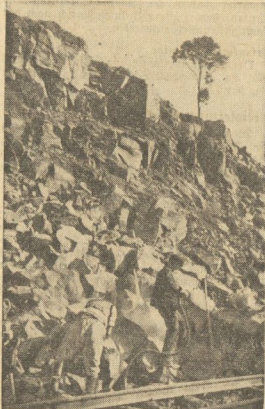
Die Rutschmassen werden abgetragen
