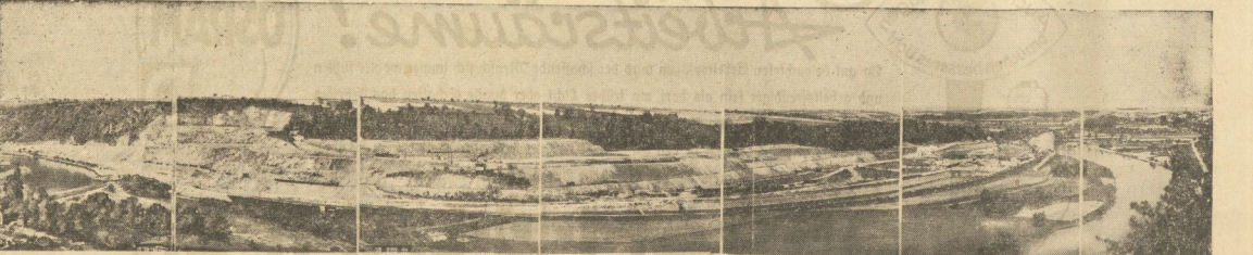
Rundblick über die gesamte Baustelle an der neuen Rothenburger Schleuse
