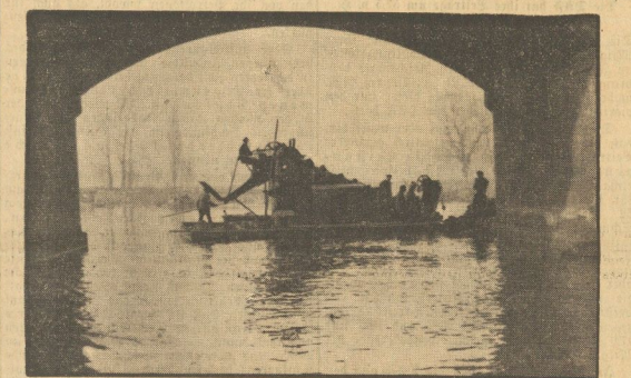
Tagger verteilt das Fußbett unter dem Brückenbogen Aufnahme: Pernau
