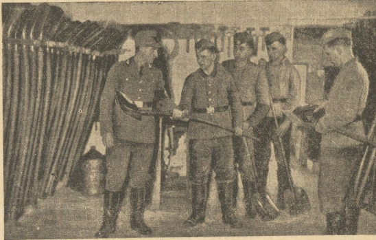
Blitzblank werden die Spaten am letzten Arbeitstag abgegeben
