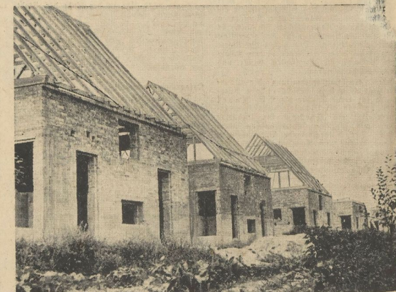
Schon werden auf die ersten zwölf Häuser die Dachstühle aufgesetzt
