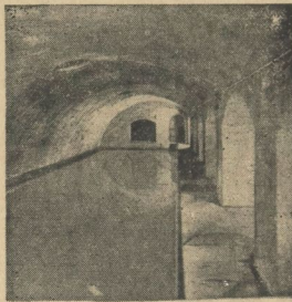
Teilansicht und Langsamfilterkammer des Pumpwerks Beesen
