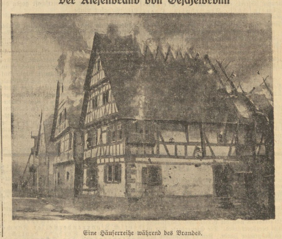
Eine Häuserreihe während des Brandes.
