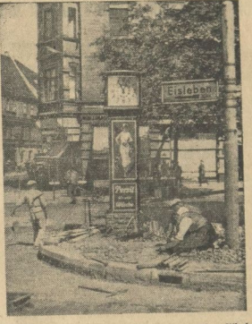
So wurde die Platzverweiterung durchgeführt
