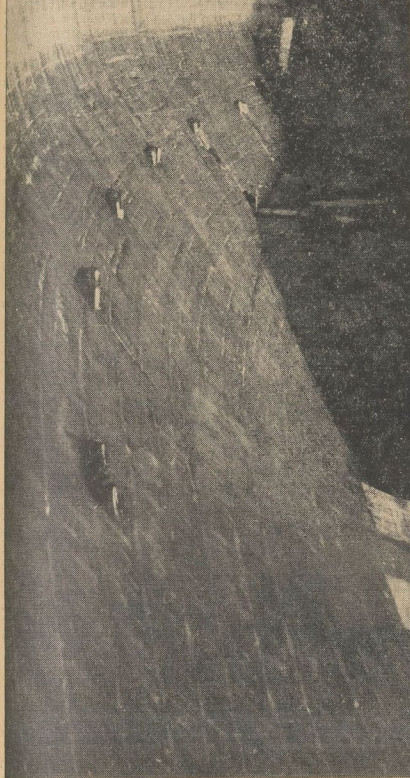
Hinter der gewaltigen Sperrmauer, die ein riesiger Betonklotz von 180 000 Kubikmeter ist, liegt der Stausee. 65 Meter ist diese bogenförmig geschwungene Sperrmauer, die eine Sohlenbreite von 47 Meter und eine Kronenbreite von 7,29 Meter hat, hoch. Die Kronenlänge beträgt 205 Meter. Dieses wahrhaft gigantische Bauwerk hält den Stausee, der bis zu 225 Millionen Kubikmeter Wasser fassen kann. Druckrohre, die am Einlauf einen Durchmesser von 6 Meter und am Auslauf von 4,80 Meter haben, führen das Wasser ins Kraftwerk. (Aufn.: M. H. B. - Bildarchiv)
