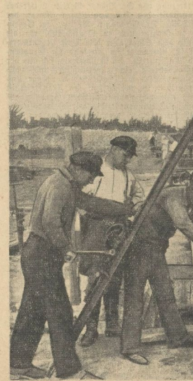
Steinzeugröhre werden in sieben Meter-tiefe Schächte versenkt
