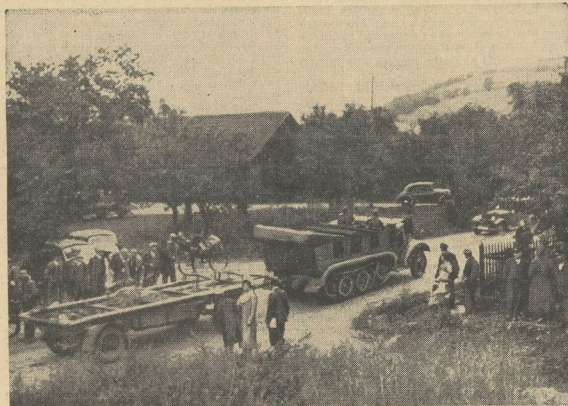
Ein motorisierter Pontonwagen passierte die fertiggestellte Brücke
