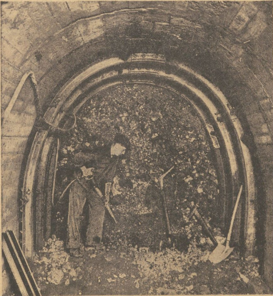
Auf einer Zechen im Ruhrgebiet baut eine Gruppe des Arbeitsdankes große Gasschloten, wobei die Kameraden gleichzeitig als Facharbeiter ausgebildet werden. Die Zechenverwaltung übernimmt laufend die bewährten Kameraden in feste Arbeitsbezüge
