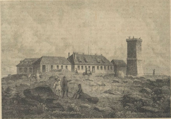
Der Brocken nach einem alten Stich
