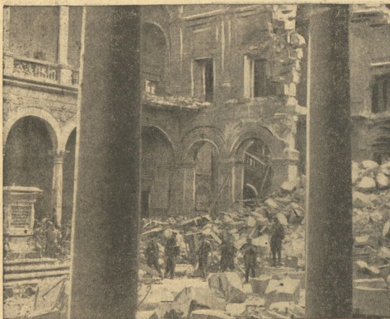
So sieht es zwischen den Trümmern des Alcazars aus. Auch die Innenhöfe sind durch die Beschießung größtenteils zerstört
