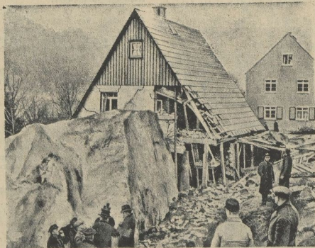
Durch Unterspülung einer etwa 30 Meter hohen Felsmaße bei Bad Schandau ereignete sich ein Felssturz, bei dem etwa 5000 Kubikmeter zu Tal gingen. Ein Block von etwa 7000 Zentner Gewicht stürzte dabei, wie uns ein Bild zeigt, auf ein Siedlerhaus und beschädigte es so schwer, daß es geräumt werden mußte.
