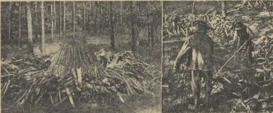
Links: Der Meiler wird aufgebaut — Rechts: Ausinanderziehen des Meilers
