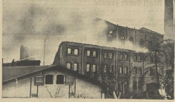
Bis auf die Umfassungsmauern brannte die Zuckerfabrik nieder
