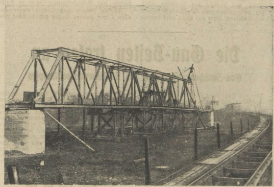
Rechts die alte, links die neue Brücke der Pfännerschaftlichen Kohlenbahn. Die neue Brücke muß bis zum 28. März fertiggestellt sein, da im Anschluß daran die Ausbaggerung für den Mittellandkanal hier weitergeht
