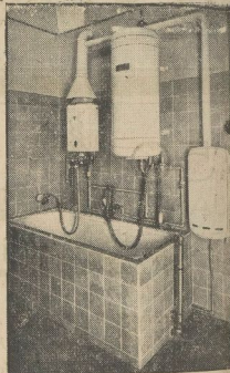
Gas- u. elektrisch. B.d.wasserbereitung (Gasheizung im Bad)
