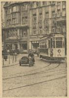
Die Einmündung der Ludwig-Wucherer-Straße besitzt zwischen Straßenbahn und Gelsteig einen zu schmalen Fahrdamm, der nun durch Verlegung der Straßenbahn verbreitert wird
