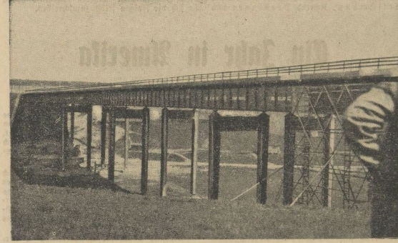
Die 250 Meter lange Stahlbrücke bei Tautendorf
