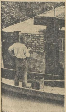
Der starke Verkehr macht an den Schleusen ständig Ausbesserungsarbeiten notwendig. Hier wird das hölzerne Schleusenwerk bei niedrigem Wasserstand vorsorglich geteert
