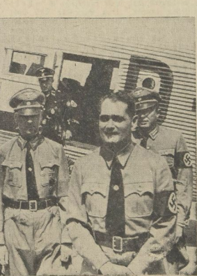
Auf dem Flugplatz Halle-Leipzig (von rechts nach links): Der Stellvertreter des Führers, Pg. Rudolf Heß, nach seiner Ankunft, Gauleiter Staatsrat Eggeling, Reichsstatthalter Gauleiter Jordan und stellvert. Gauleiter Tesche
