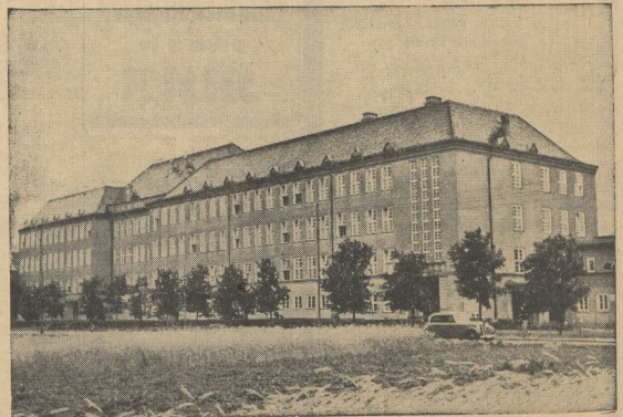
Ein schmaukes Gebäude ist die Friedensschule
