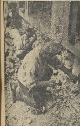
Neuer Werksteinsockel unter den Fenstern im Erdgeschoss entsteht bereits
