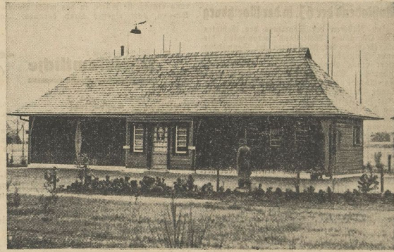
Straßenbahn-Wartehäuschen am General-Maercker-Platz im ländlichen Stil
