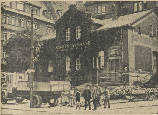
Durch Abtragung von Vorgartengelände wird der Rannische Platz erweitert
