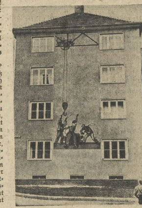
Aufnahmen: DRG-Blätterdienst Arbeiter am Kran
