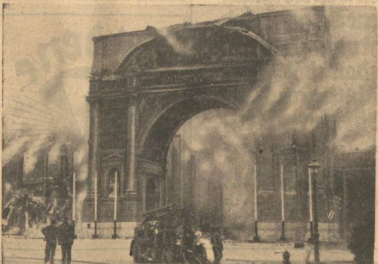
Am 18. September wurde die Wiener Rotunde durch ein Riesenfeuer in wenigen Stunden bis auf die Grundmauern vernichtet
