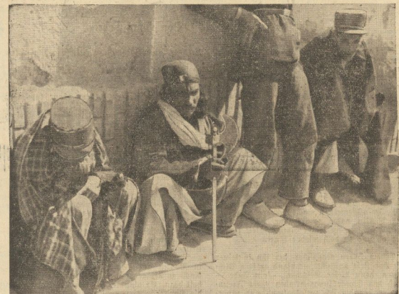
Die Patienten warten im Freien. Wart- und Sprechzimmer des Arztes ist hier die Straße
