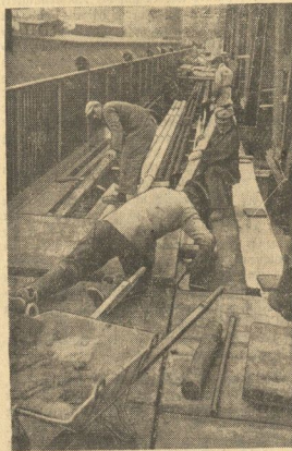
Und nun wird der Fußgängerweg wieder hergerichtet
