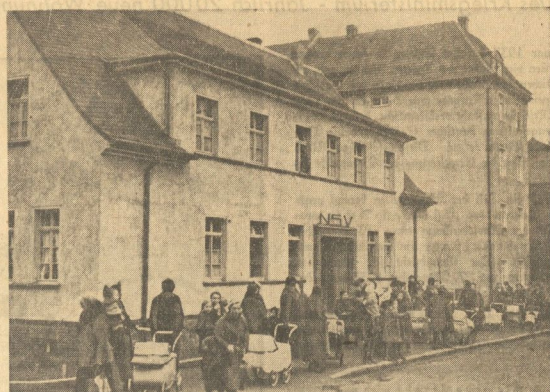
Das „Haus der NSV.“ in Weida, der modernste Kindergarten Thüringens. Das Gebäude wurde in Gemeinschaftsarbeit errichtet
