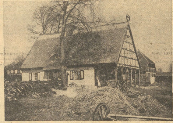
Schöne alte Bauernhöfe sollen unter Denkmalschutz gestellt werden
