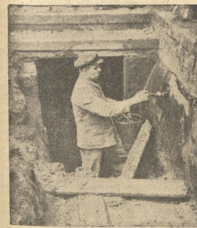
Fundamente unter der Erde mit Asphalt gestrichen und isoliert
