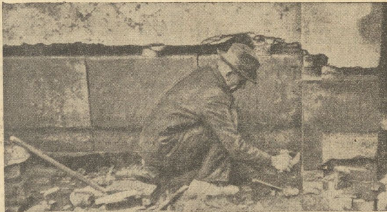
Die Mauern wurden zuletzt auch auf der Hofseite des Rathauses durchgeschnitten
