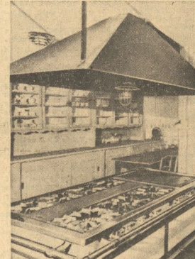
Die warme Luft in der Küche wird durch den Schornstein über dem Herd abgesaugt; die Zuführung der künstlich vorbehandelten Luft erfolgt durch die an der Decke sichtbaren Apparate
